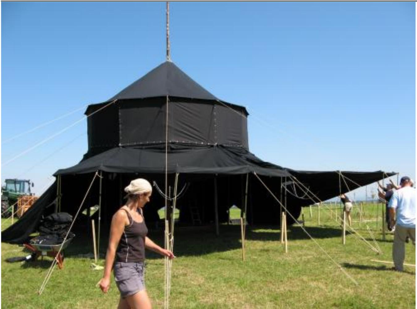
Sobald alle Dächer angebracht sind kannst du diese gleichmäßig nach aussen abspannen. Bitte achte darauf, dass sich der Dom in der Mitte nicht verdreht. Wenn du dich an die ausgemessenen Abspannpunkte hältst ist das recht einfach.
