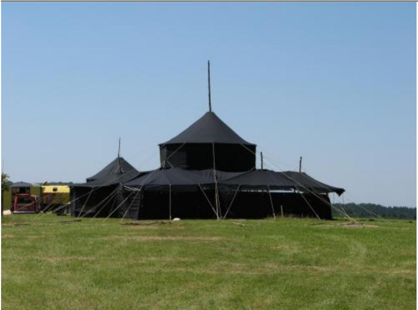
Hier ist die große Jurtenkostruktion fast fertig, es fehlen noch die Jurtenabdeckplanen über den Rauchlöchern und einige Abspannungen zwischen den Jurtendächern.
