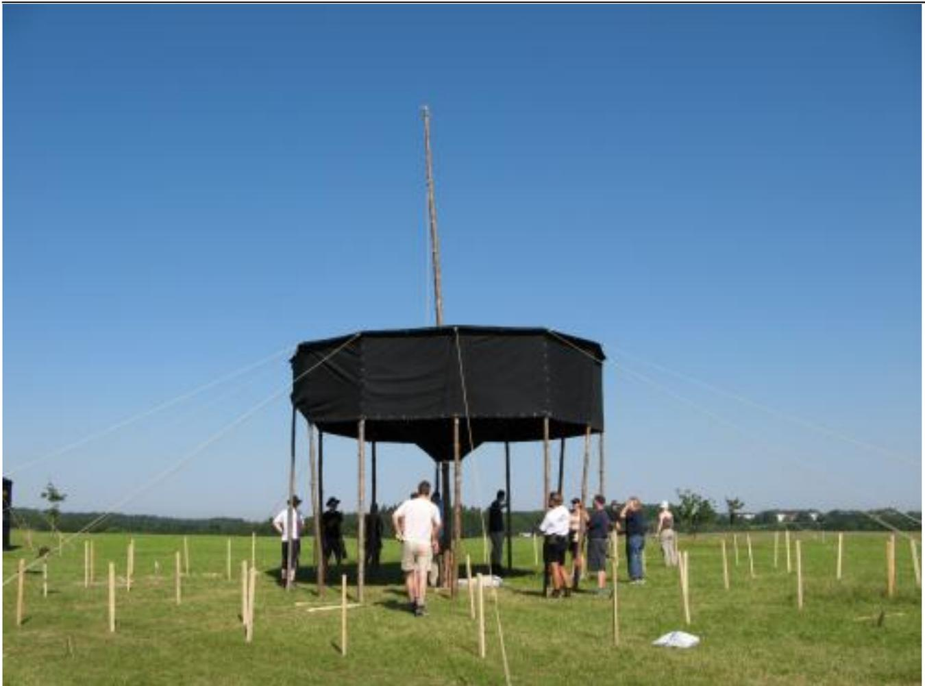
Als nächstes legst du alles Baumaterial parat und beginnst mit dem doppelstöckigen Mitteldom. [Die Höhe der Stangen errechnet sich](#) [2] aus der Höhe deiner Seitenwände und dem Höhengewinn durch die Dachneigung der äußeren Jurten.
