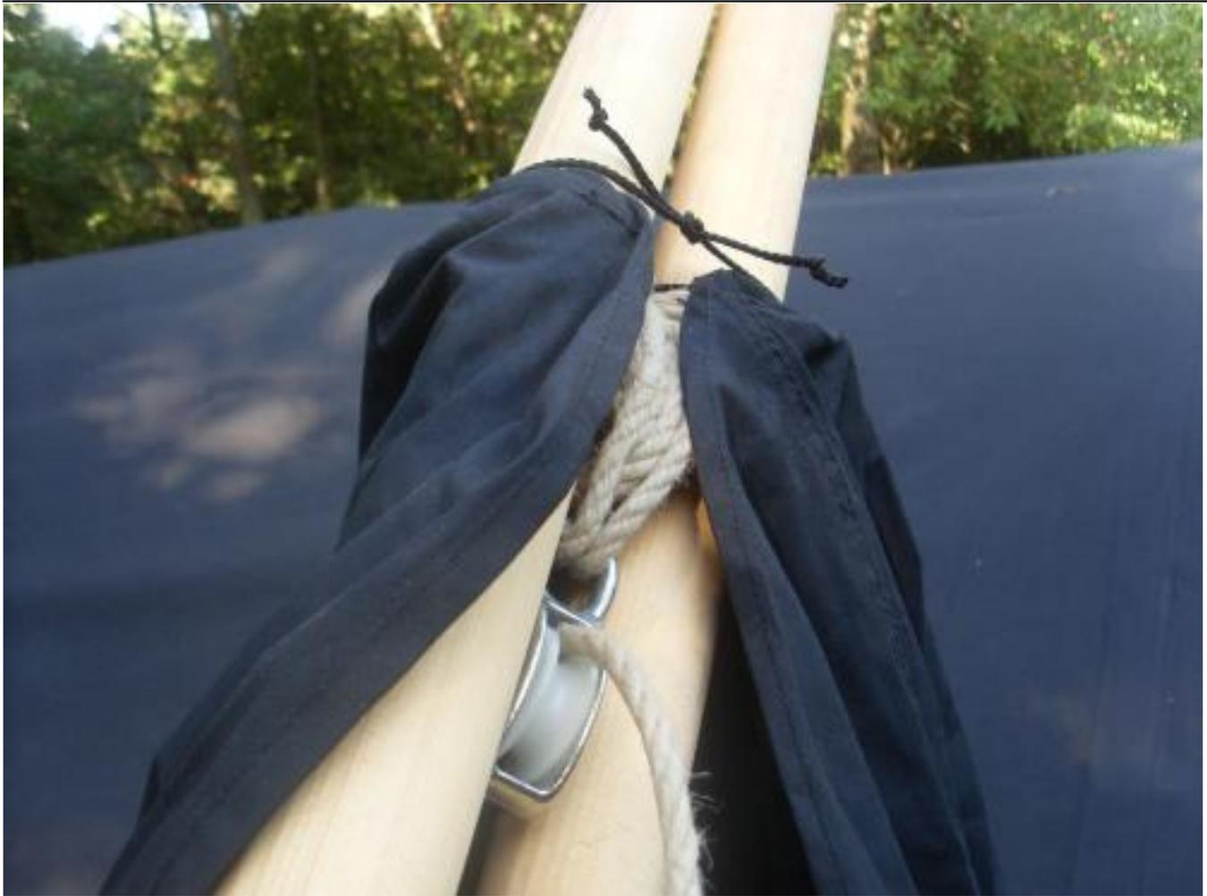
Wichtig ist die Entscheidung, wie hoch die Abdeckplane später über dem Rauchloch hängen wird. Soll sie dicht schließen und der Stoff möglichst auf dem Jurtendach aufliegen? Oder soll dir ein mehr oder minder großer Spalt für den Rauchabzug bleiben? Das legst du bereits mit dem Bindepunkt der Mittelstangen fest. Denn idealerweise wird an dieser Stelle auch die Jurtenabdeckplane um die Stangen gebunden.
