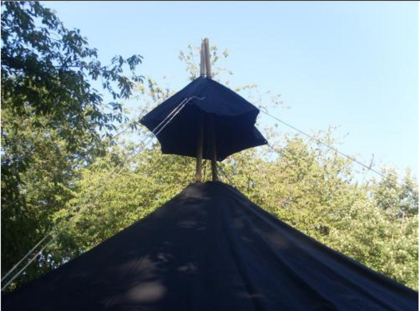
Für die Jurte gibt es erstmal nur eine Standardgröße. Ob 5 Meter, 6 Meter oder 8 Meter. Die Rauchlöcher sind alle gleich groß, bzw. brauchen die gleiche Jurtenabdeckplane. Nur wird hier zwischen einer "alten Ausführung (AA)" und einer neuen Variante "mit Rundleine (RL)" unterschieden. Bei letzterer Abdeckplane sorgt ein zusätzlicher Stoffstreifen für das dichtere Aufliegen auf dem Dach.
