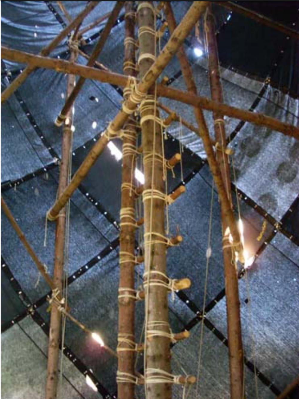
Uns gefällt die Einfachheit, mit der dieses große Zelt aufgestellt wurde. Keine Jurtenschrauben, keine Stahlpföcke, sondern Schnur und Holz halten das Konstrukt. Und auch bei kräftigeren Winden wabert zwar etwas die Hülle aus Stoff, aber die Kathedrale als solche steht sicher verankert da. Fast wie für die Ewigkeit...
