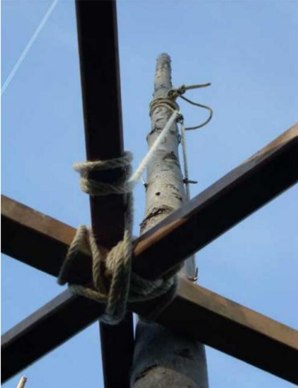
Das Dach der Jurte hängt üblicherweise an eine Kette oder an einem Kreuz. Und obwohl es schwer und unhandlich ist, ist das Jurtenkreuz die eleganteste Variante, das Dach der Jurte nach oben zu bringen. Drei Holzstangen mit sechs Metallbeschlägen straffen das Dach an der entscheidenden Stelle und machen das ordentliche Abspannen einfacher als bei einem Dach mit Kette (bzw. Spinne).
