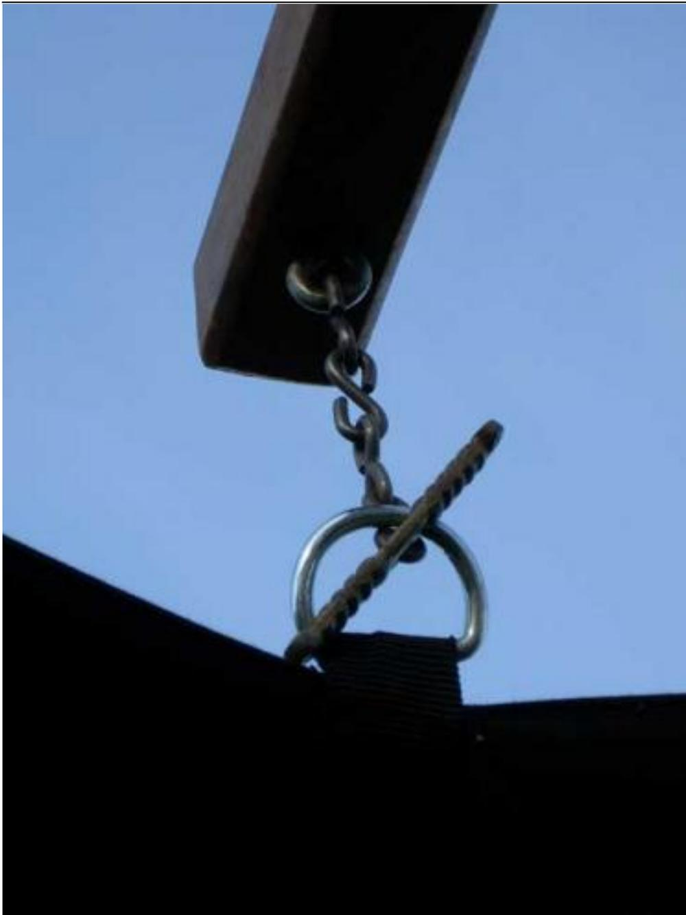
Am Dach selbst wird das Jurtenkreuz mit passenden Beschlägen aus Metall eingehakt. In diesem Fall ist dies ein Komplettdach mit D-Ringen. Bei einer Jurte aus einzelnen Kohtenbahnen wird der Beschlag durch die Ösen in den Ecken der Kohtenbahnen geführt.
