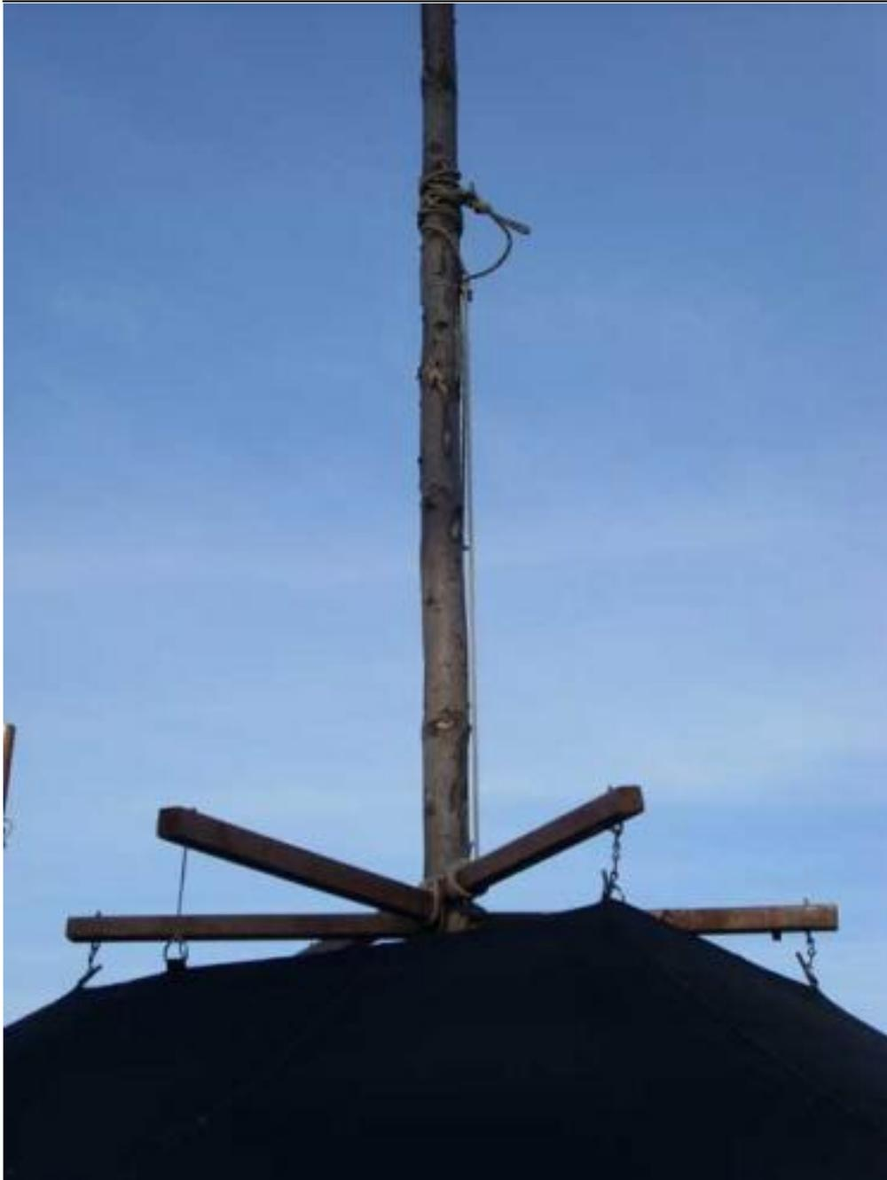
Das Dach ist sauber an dem Jurtenkreuz aufgespannt. Lediglich der Bund am Mast (Einbein) mit der Blockseilrolle ist etwas weit oben angebracht. Allerdings ist dies bei dieser Konstruktion unwesentlich, wo die Rolle angebracht wird, solange sie ein Stück über dem Kreuz ist. Die Jurtenabdeckplane für das Rauchloch kann hier auch sehr gut angebracht werden, indem du sie einfach an der passenden Stelle um den Mast bindest.
