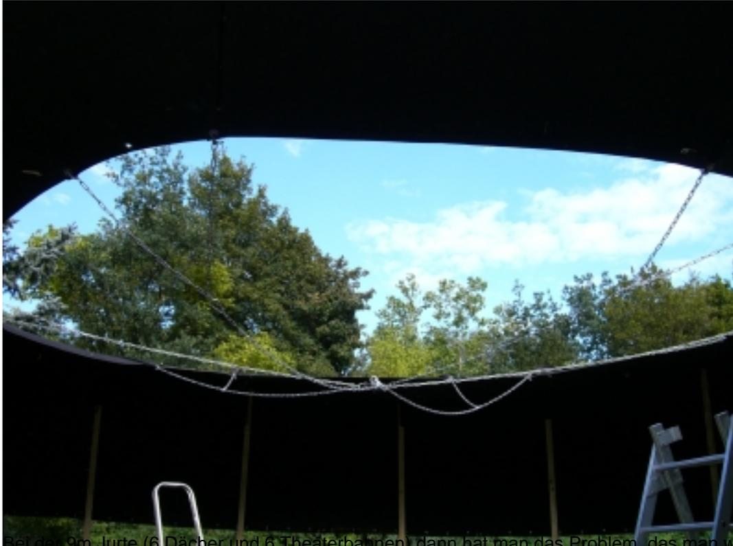
Bei der 9m Jurte (6 Dächer und 6 Theaterbahnen) dann hat man das Problem, das man wenn man aus der Mitte die Spannseile ziehen möchte, die Zugkraft nicht in Richtung der Nähte auftritt. Was fatale Folgen für die Nähte der Bahnen hat. Um das ganze zu verhindern kann man die Kräfte der Kette mit Y-Stücken umlenken. Siehe Zeichnung. So heben sich die Kräfte gegenseitig auf. Und man kann die Jurte gefahrlos mit der Kette aufbauen.
