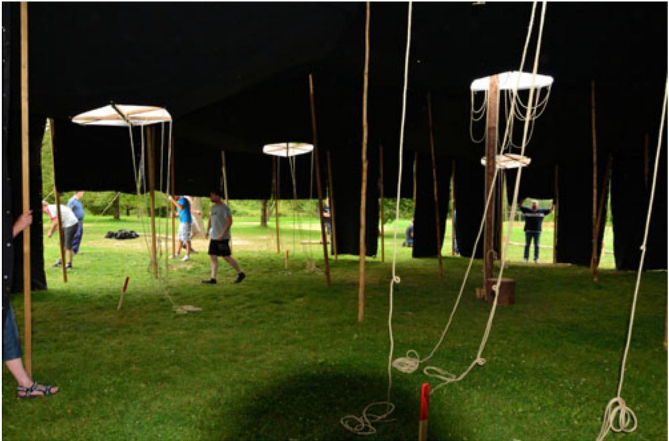
Von innen sieht die Jurtenskonstruktion inzwischen so aus. Später werden hier nur noch sieben Stützen stehen. In jedem Rauchloch eine. Diese tragen das komplette Dach und an den Verseilungen dazwischen können alle anderen Aufhängepunkte abgespannt werden. Gut, wer hier den Überblick bewahren kann.
